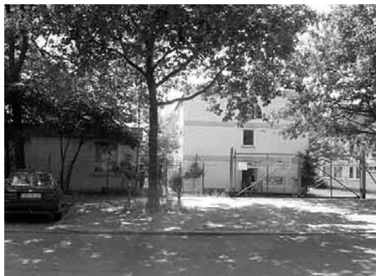
Motardstraße 101a in Spandau.
